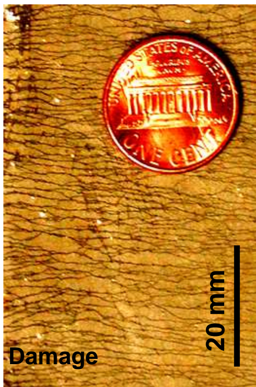
飽和状態における微細亀裂
