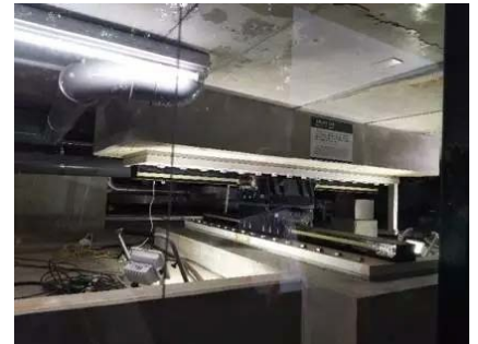
能耗可视化平台及建筑基层处使用软橡胶支撑
